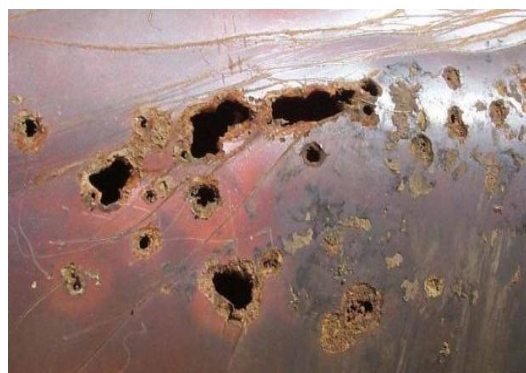
ภาพที่ 13 การเกิดสนิมหลุมทำลายสิ่งก่อสร้าง
