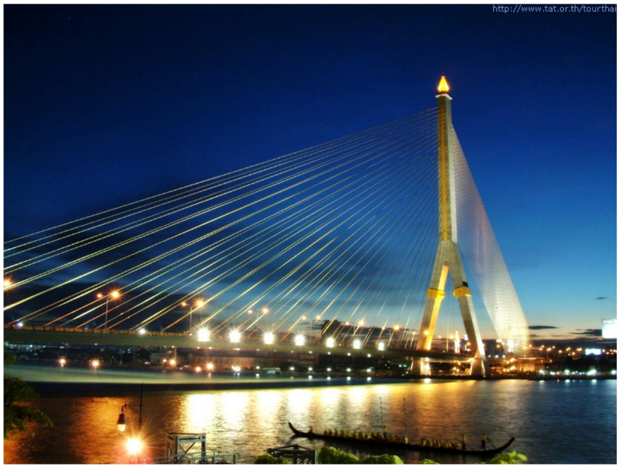
สะพานพระรามแปด จ.กรุงเทพมหานคร
