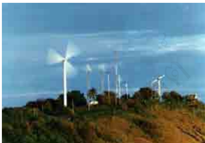
รูปที่ 2.37 สถานีผลิตไฟฟ้าจากพลังงานลมร่วมกับระบบเซลล์แสงอาทิตย์ของการไฟฟ้าฝ่ายผลิต
