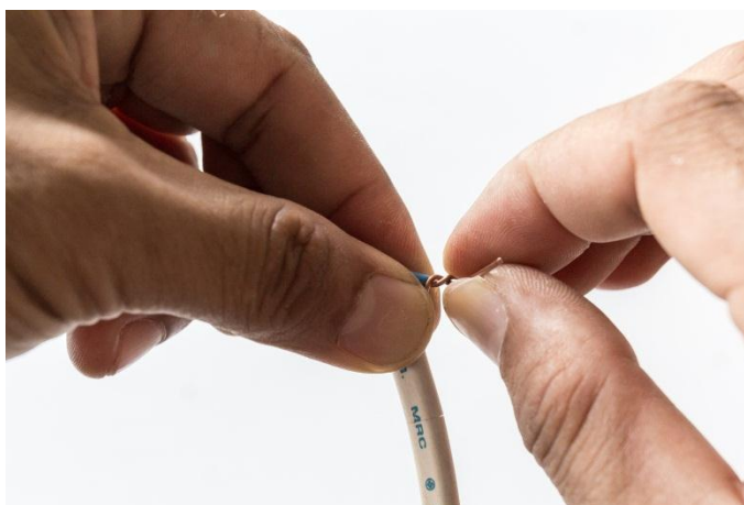
รูปที่ 39 การพันสายไฟฟ้าแบบสายคู่ สาย VAF (ที่มา นายอภิชาติ ทดราช : 2 มีนาคม 2562)
