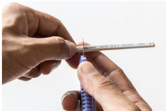
รูปที่ 36 การตัดสายไฟฟ้าชนิด VAF (ที่มา นายอภิชาติ ทดราช : 2 มีนาคม 2562)
