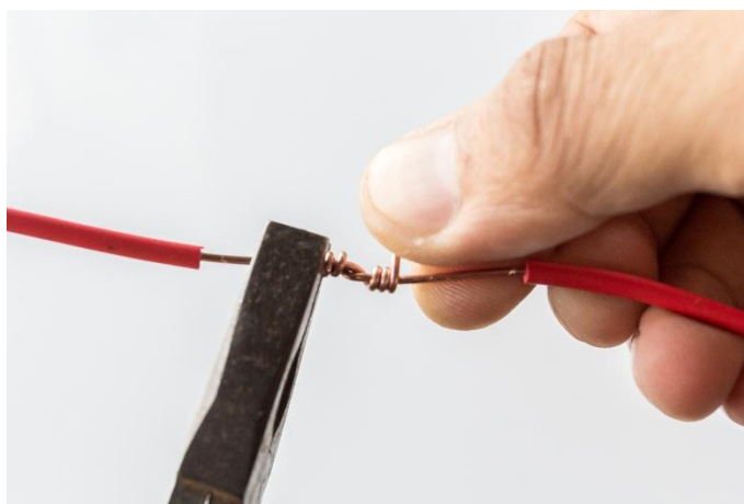
รูปที่ 13 การพันสายแบบรับแรงดึง (ที่มา นายอภิชาติ ทดราข 2 มีนาคม 2562)
