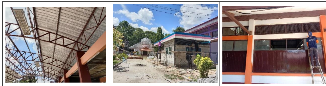
➔ ปรับปรุงซ่อมแซม อาคารเรียน
