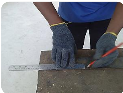
ภาพที่ 16 วัดและทำเครื่องหมายบนชิ้นงาน
