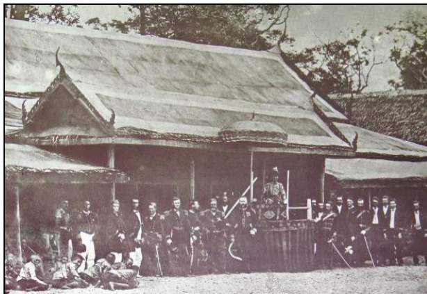
ภาพ 7 รัชกาลที่ 4 เสด็จพระราชดำเนินไปทอดพระเนตร สุริยุปราคาที่ตำบลหว้ากอ จังหวัดประจวบคีรีขันธ์ เมื่อ พ.ศ. 2411 ซึ่งสุริยุปราคาได้เกิดขึ้นตรงตามที่พระองค์ทรงคำนวณไว้
