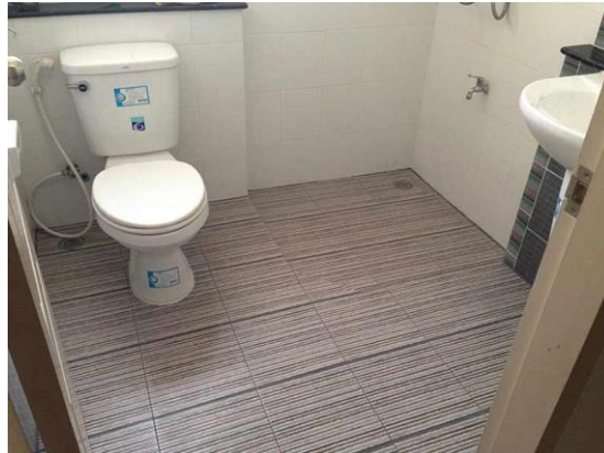
รูปที่ 1.7 แสดงการปูพื้นห้องน้ำด้วยการใช้กระเบื้องที่มีผิวขรุขระเพื่อเพิ่มแรงเสียดทาน
