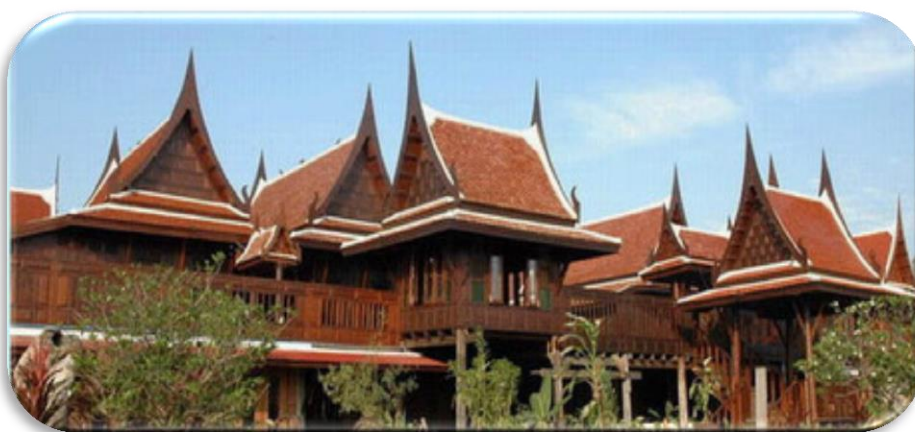
ภาพที่ 31 บ้านเรือนแบบไทยเป็นเรือนเครื่องสับ ที่มีโครงสร้างเป็นไม้จริงประกอบกัน โดยใช้เจาะเดือยไม่ใช่ตะปู สะดวกในการรื้อถอนเคลื่อนย้าย
